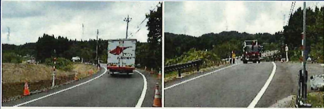
仮設道路の片側交互通行状況（小矢部市内山地内）
